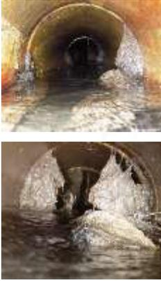
Разработанный комплекс предназначен для обследования загрязненных трубопроводов ЖКХ диаметром от 100 до 300мм.
